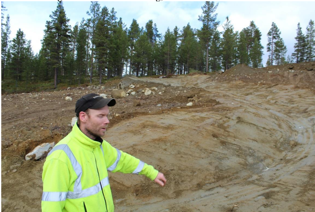
Bilde: Ferdig formet siste kurve, pynting og fjerning av stein utenfor banen gjenstår. Fagmann bak spakene i gravemaskinen er avgjørende for å få til et sluttprodukt med høy kvalitet. På Mån var løypekjører også vesentlig i det praktiske arbeidet med designen av banen. Vurdering av hvordan maskinen skal preparere løypa, vurdere hvordan 1 meter snø legger seg i anlegget og hvordan dette skal preppes med maskina. Vurdere om løypemaskinen trenger egne arealer for å vende og snu og kjøre inn og ut av anlegget. Smart design gir rasjonelt preparering og vedlikehold av anlegget gjennom vintersesongen.
